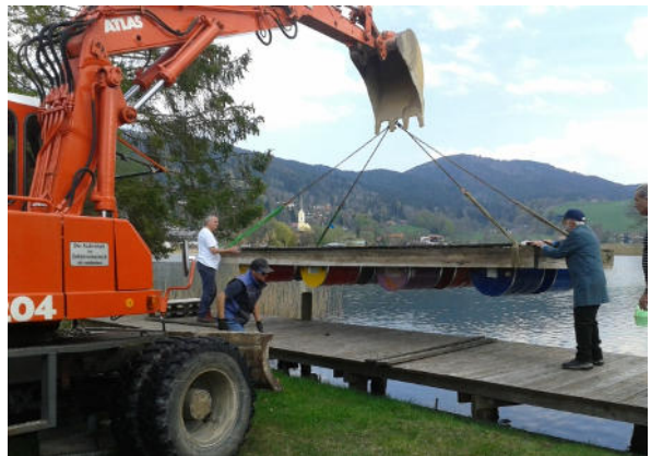
Einsetzen des Schwimmstegs
